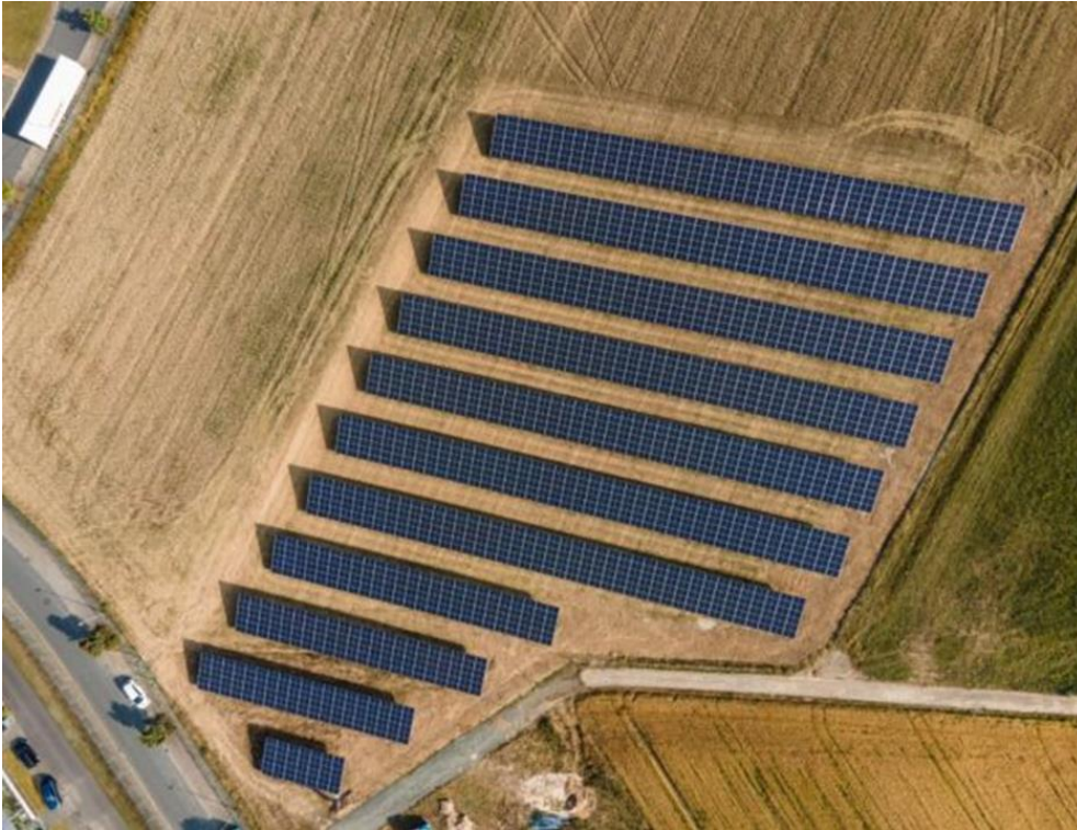
Bürgerbeteiligung an PV-Anlage Salzbödetal / Gemeinde Angelburg
